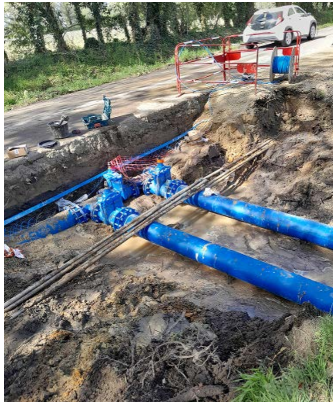
Pose de canalisation fonte
