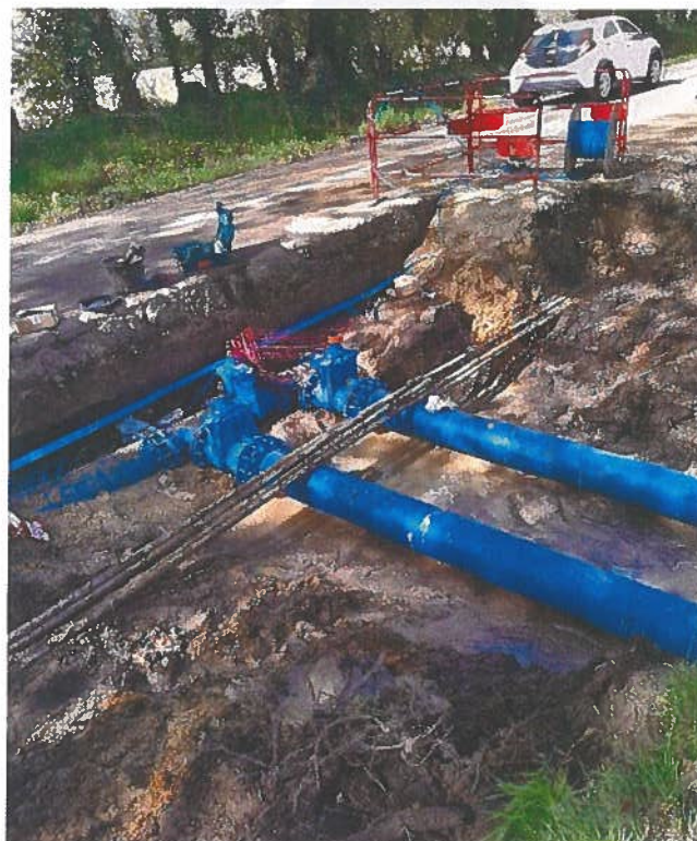
Pose de canalisation fonte
