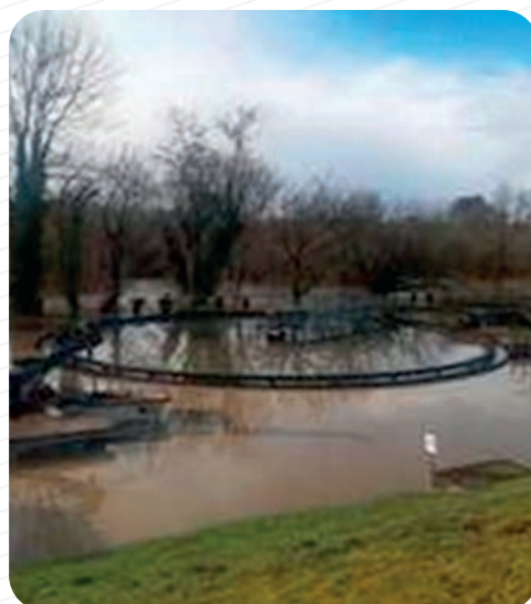
| Station d'épuration de Jouanas : premier janvier 2021
