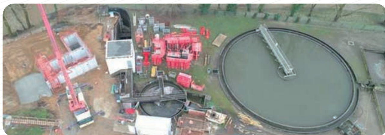
| Construction du poste de relevage en entrée de station
