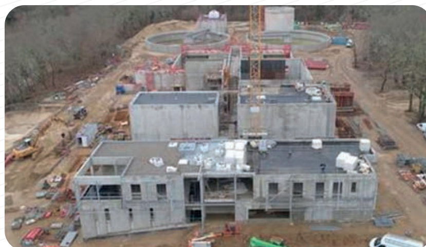
| Vue axiale du chantier
