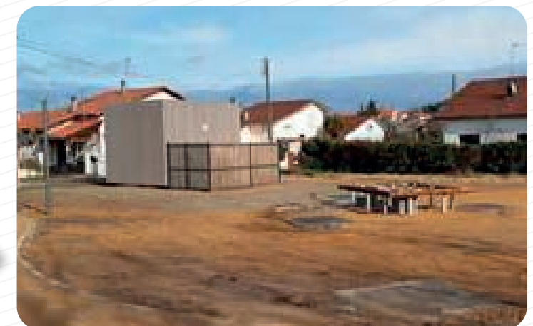
| Bassin Barbe d'Or : local technique et aménagement parking en cours
