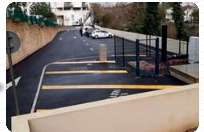
| Bassin Lesbazeilles : reconstruction du Parking Delamarre
