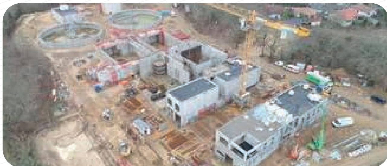
| Avancement du chantier
