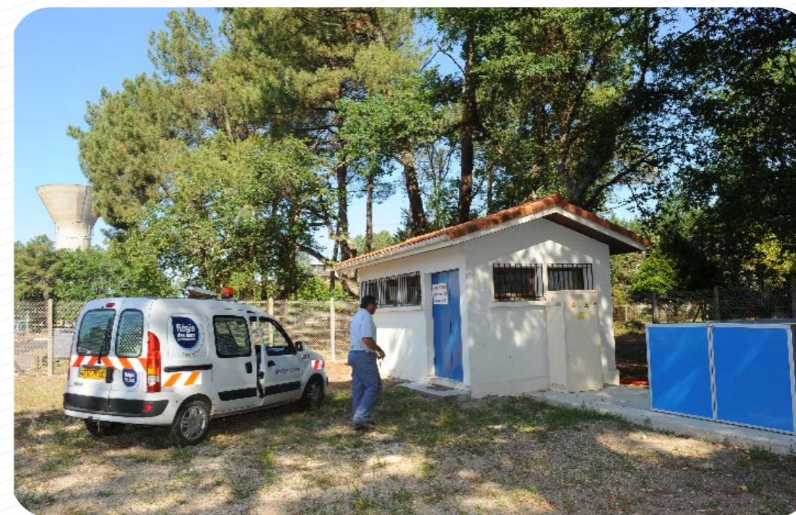
| Figure 4 : vue d'un forage d'eau potable
