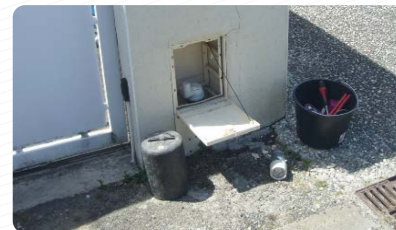
Figure 8 : Changement d'un ancien compteur par un télérelevé
