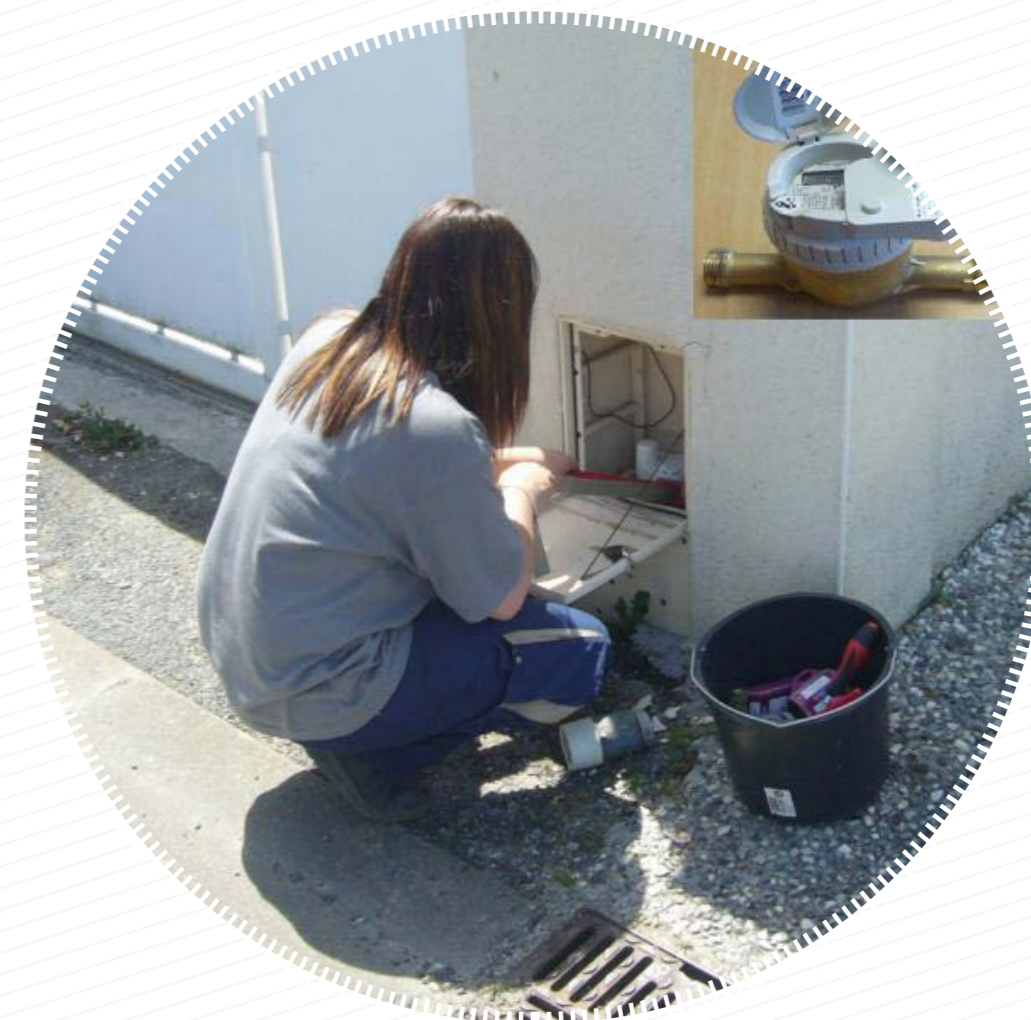
Figure 3 : Vue d'un compteur télérelevé
